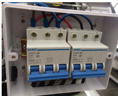
Переключатель двигателя в электрической коробке
